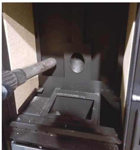
Fig.93 Nettoyage de l'échangeur à l'arrière du foyer
