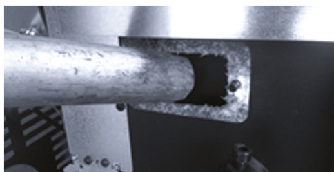
Fig.95 Aspiration des suies par les trappes latérales
